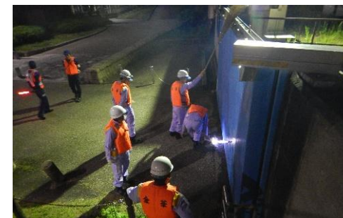
大宮第二陸閘
